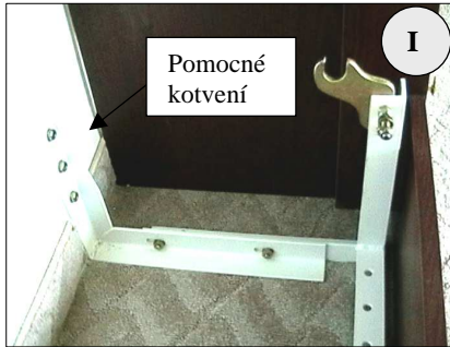
POMOCNÉ KOTVENÍ DO STĚNY
